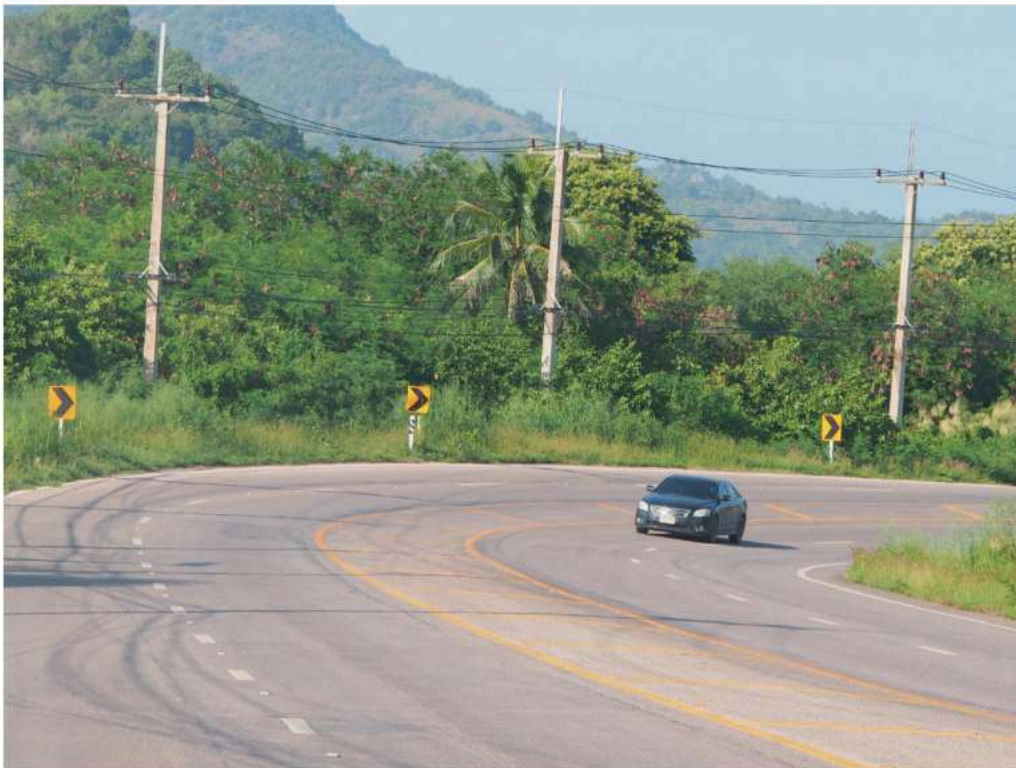
รูป 7.16 การออกแบบถนนในช่วงที่เป็นทางโค้งให้เอียง
