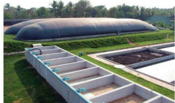
รูป 14.34 ก. ขั้นตอนการนำชีวมวลมาหมักจนได้แก๊สชีวภาพสำหรับนำไปผลิตไฟฟ้า ข. บ่อหมักแก๊สชีวภาพ
